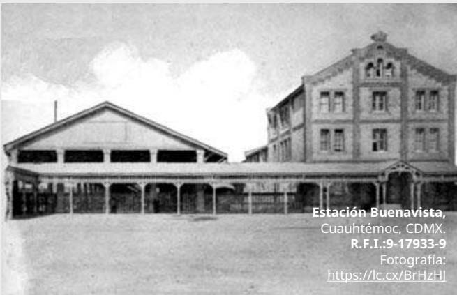
Estación del F.C. Mexicano., Cuauhtémoc, CDMX. Fotografía: https://lc.cx/BrHzHJ
